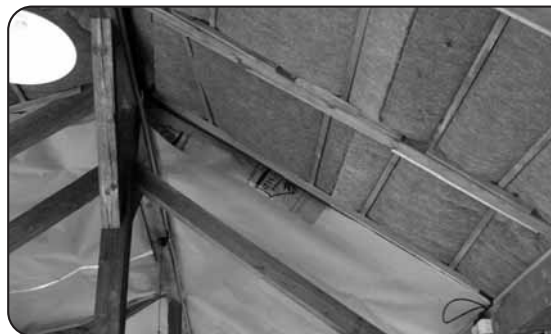
Zateplení střechy domu konopnou izolací THERMO-HANF
